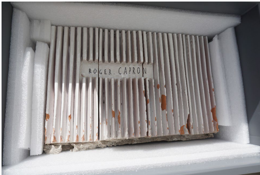
Dépose des panneaux, plage du Larvotto, octobre 2019 Numérotation de chaque carreau et mise en caisse
