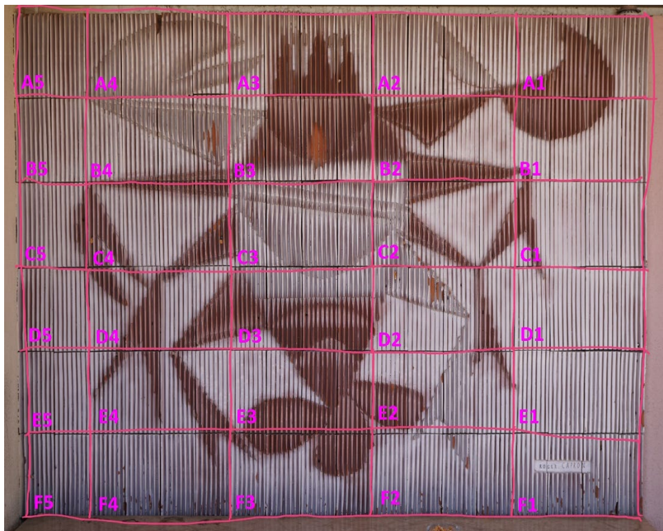
Relevé et numérotation des panneaux avant dépose
