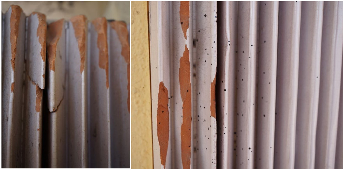
Exemples d'altérations relevées : carreaux cassés et encrassés
